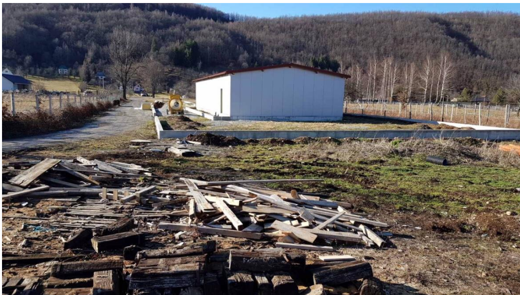
Sl.6. Objekat mini-klanice za živinu i izgradnji investitora BESTPRODUKT doo
