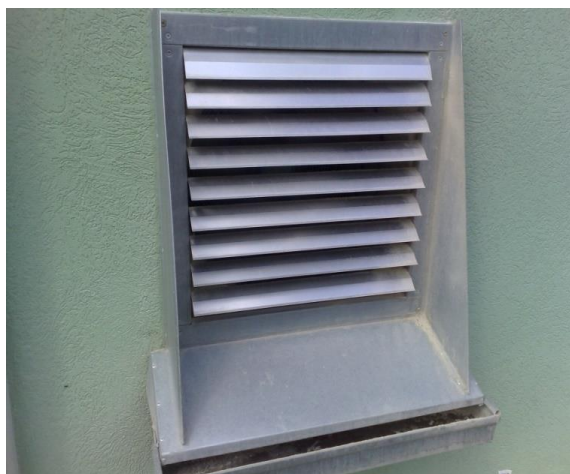
SL.30b. Usmerivač vazduha sa vodenim filterom
