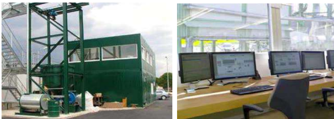
Slika 28. Spoljašnji i unutrašnji izgled kontrolno upravljančke prostorije
