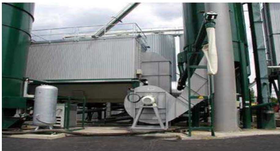
Slika 21. Izgled opreme za otprašivanje (vrećasti filter sa ventilatorom)
