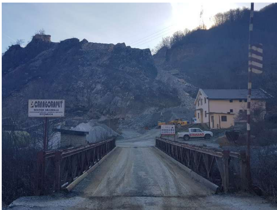
Slika 2. Izgled pristupnog puta i mosta na Štitarskoj rijeci predmetnoj lokaciji
