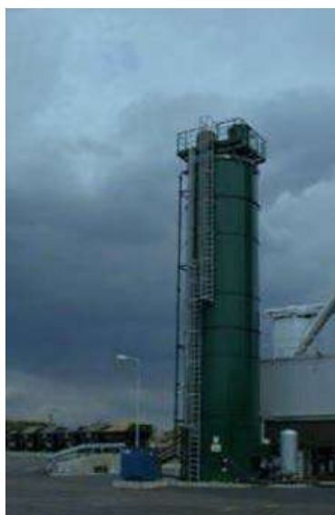
Slika 23. Izgled silosa filtera
