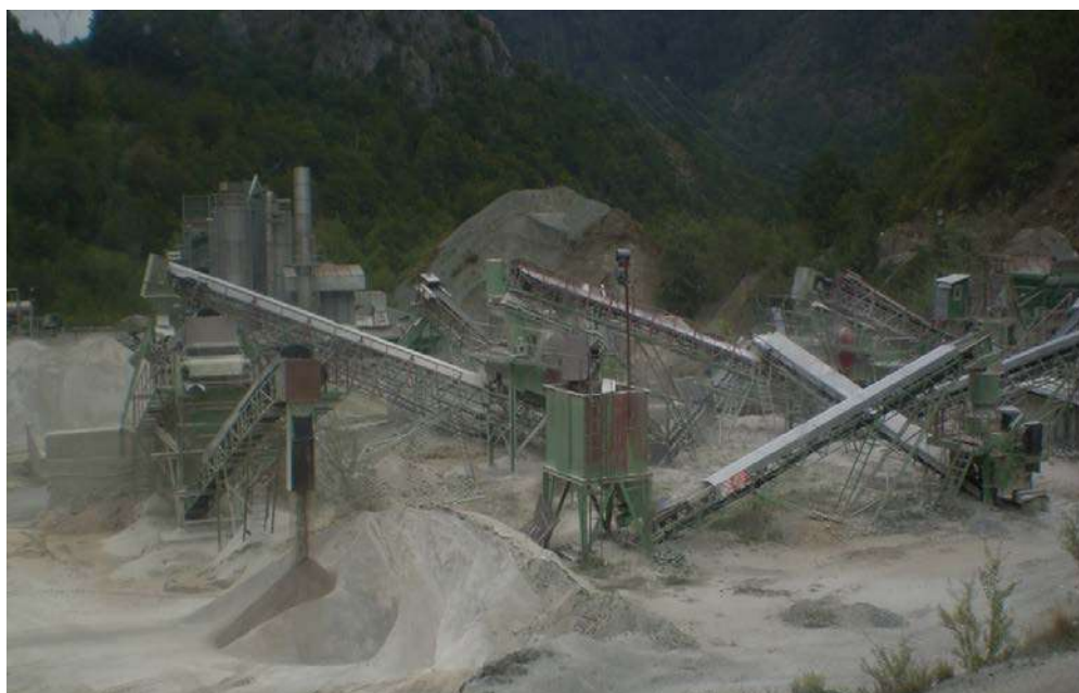
Slika 12. Izgled postojećeg Drobiličnog postrojenja kamenog agregata
