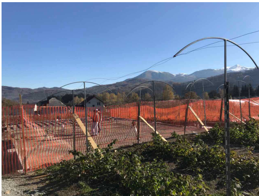
Slika 3. Lokacija budućeg objekta-hladnjače, oktobar 2017.godine
