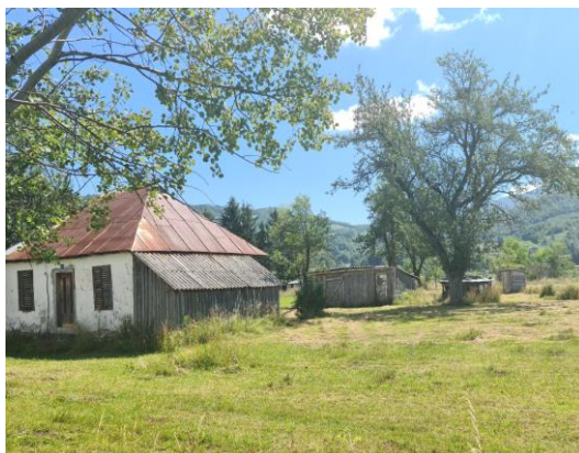
Slika 2.4. Objekat koji je predviđen za uklanjanje
